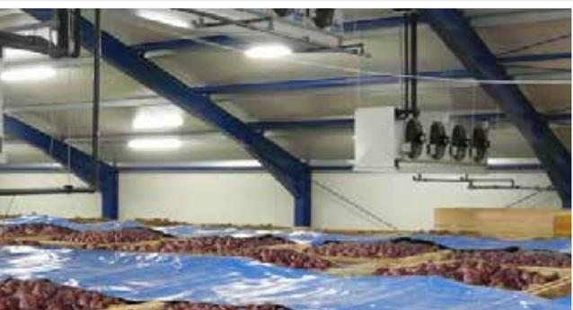
Картофель – это продукт, требующий особых условий хранения. После сборки урожай начинает дозревать. Склады создаются для того, чтобы отсрочить, по мере возможности, этот процесс. При надлежащей вентиляции и надлежащих условиях хранения гниение, потеря массы и качества продукции может быть сведена к минимуму.
